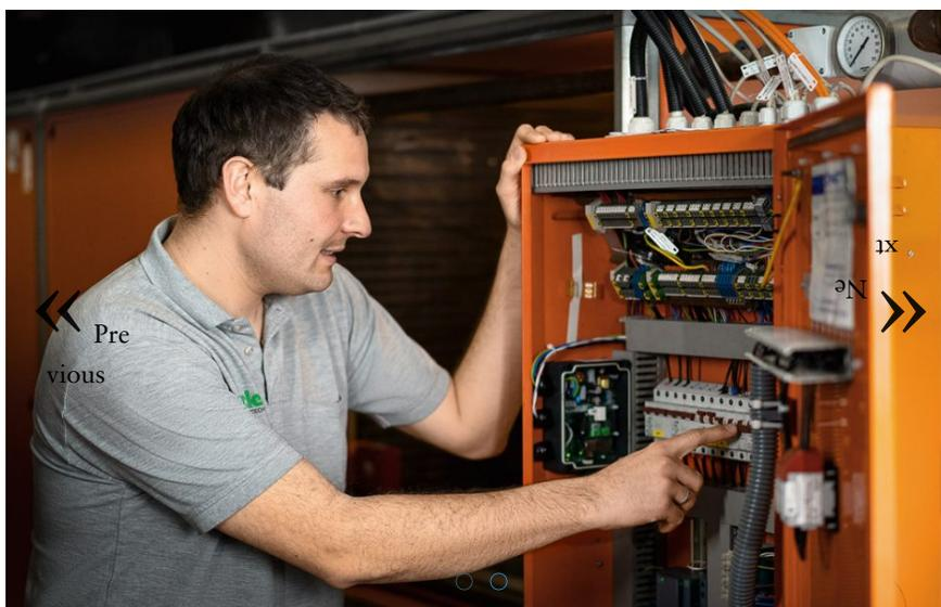
Bild 2: Der Schaltschrank der Anlage war noch gut erhalten und konnte daher ohne großen Aufwand mit der Sensorik und ebm-papst neo Gateway ergänzt werden. (Foto | Lukas Zwiessele)
