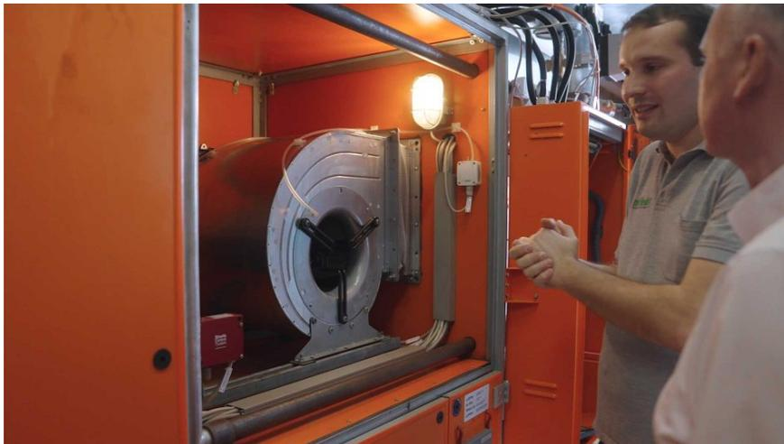
Bild 4: Die neuen RadiFit sind dank EC-Motor deutlich sparsamer und konnten schnell und einfach ausgetauscht werden. (Foto | Lukas Zwiessele)
