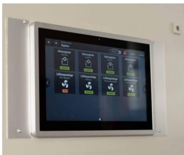
Bild 6: Über ein Bedienpanel kann der Hausmeister jederzeit die Daten der Lüftungsanlage auslesen und bei Bedarf manuell nachregeln. (Foto | Lukas Zwiessele)
