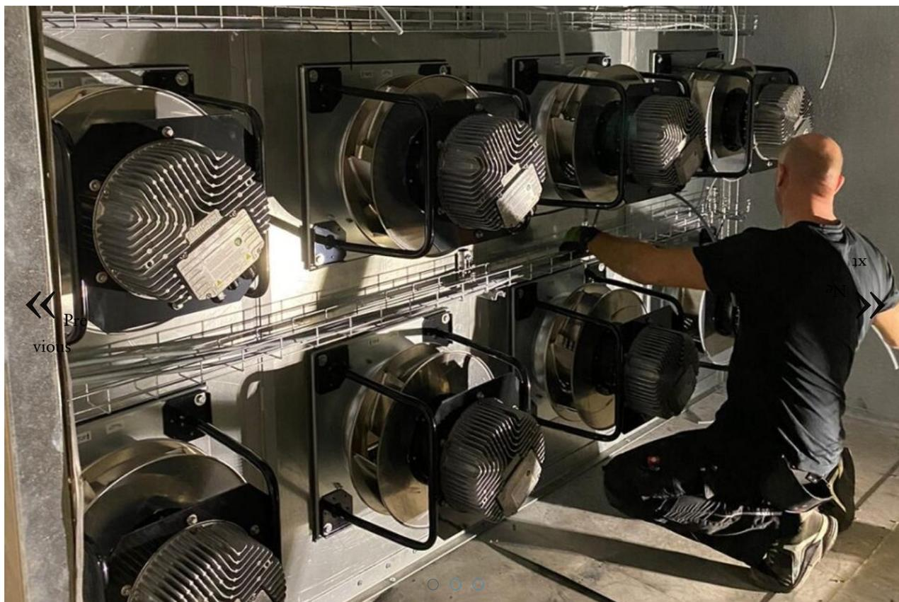
Im Museum ZeitHaus reiht sich Fahrzeug an Fahrzeug. Die neue Lüftungsanlage tut es ihm nach einem Retrofit gleich: In einem FanGrid reiht sich RadiPac an RadiPac – und spart 25% Energie ein. (Foto: ebm-papst)
